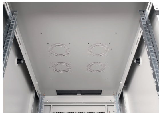
Dak met uitsparingen voor ventilatie
